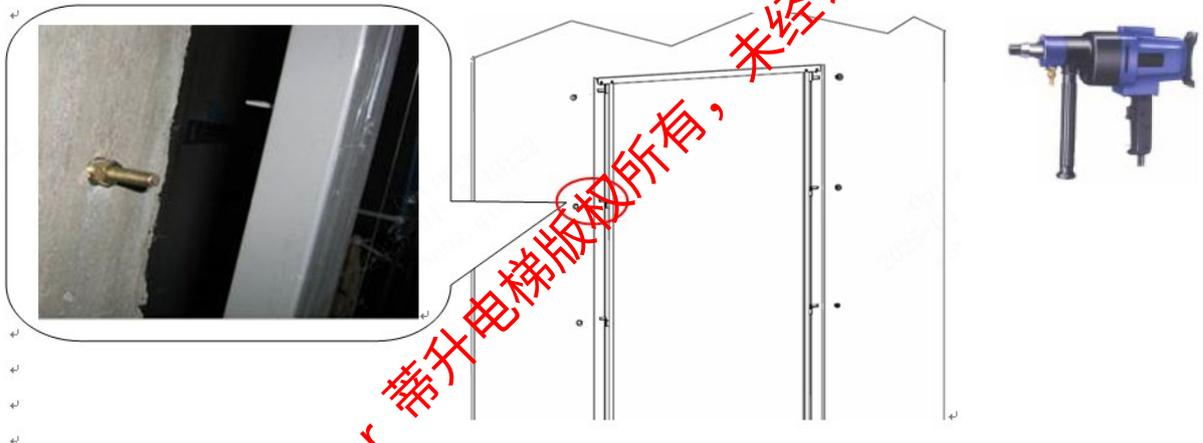
iii) 将门套前后左右位置确定好后固定门套，防止移动
