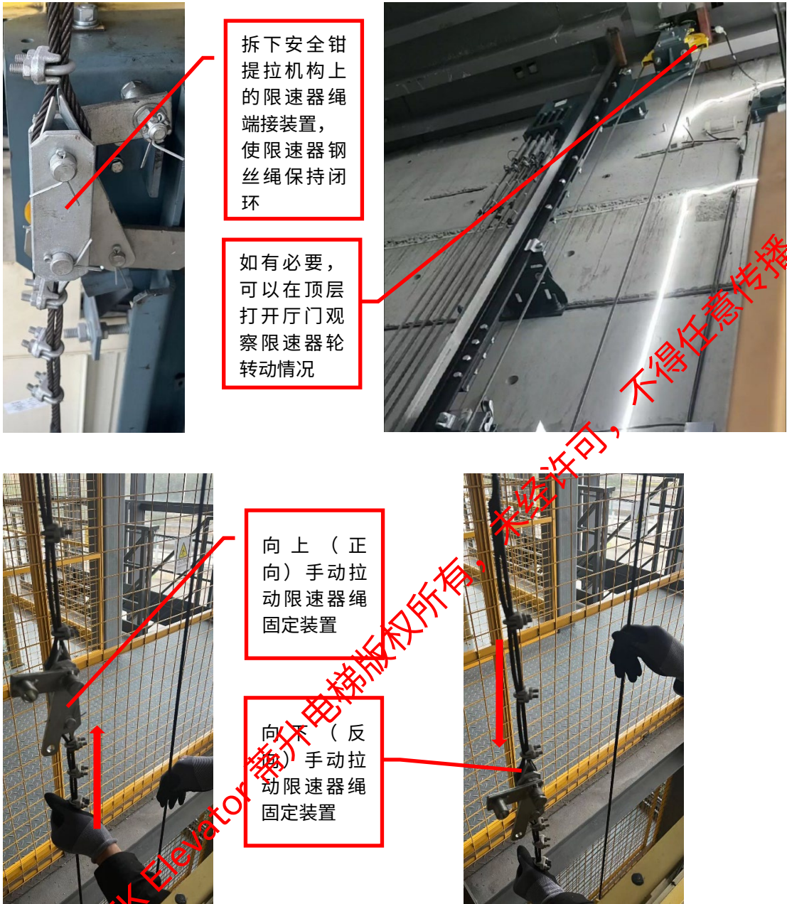
手动恢复限速器机械结构示意图（图 6）
