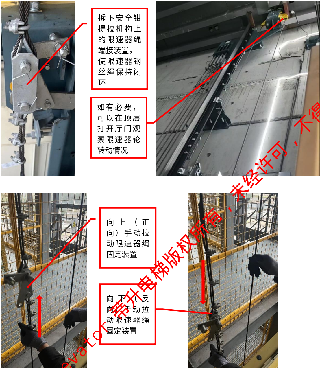
手动恢复限速器机械结构示意图（图 6）
